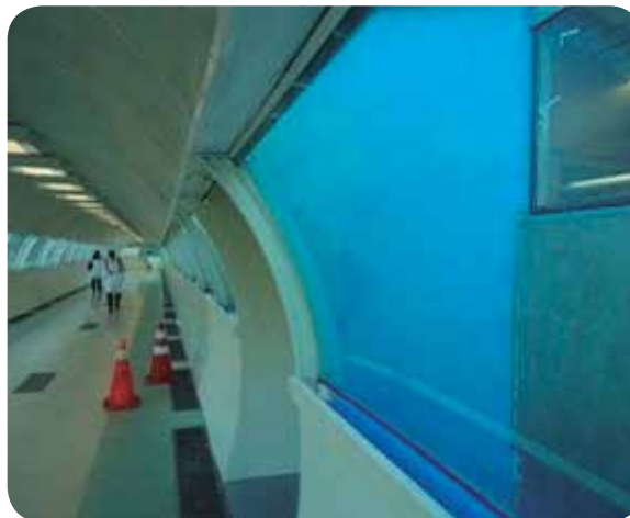
Interligação da Passarela PAMB/InCor/ICESP
