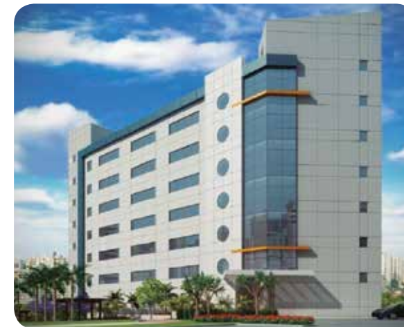
Construção do novo prédio do SAMSS
