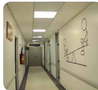
Reforma, Adequação e Modernização do 3º - PED 3
