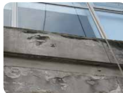
Recuperação das fachadas do InCor
