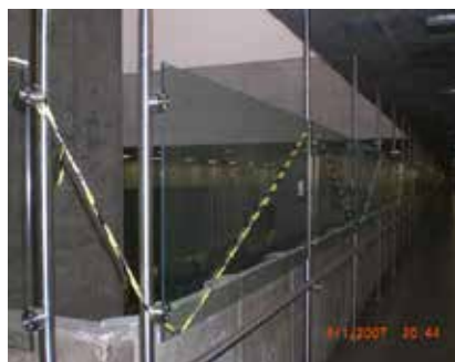
Revitalização do PAMB 1ª Fase
