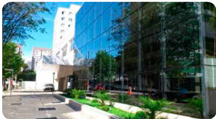
Obra Blocos I e II
